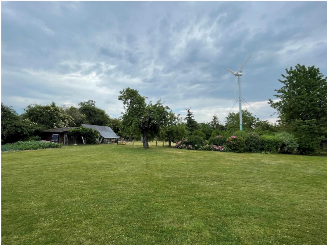
Les panneaux solaires sur l'abri de jardin et l'éolienne 4 kW
